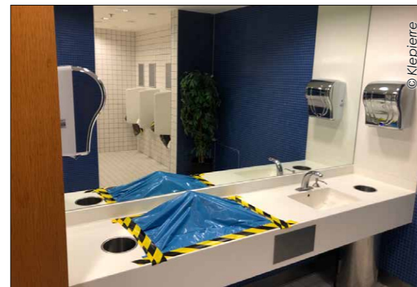
Absperrungen von Waschbecken
